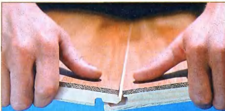
Безклевая система сборки ламината с замковым пазошиповым соединением.
